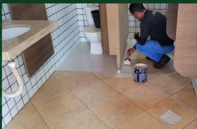
Manutenção de banheiros do CPS
