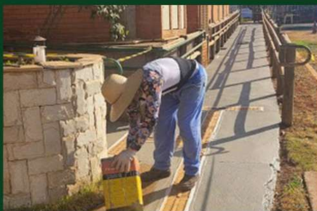
Pintura da calçada do CPS
